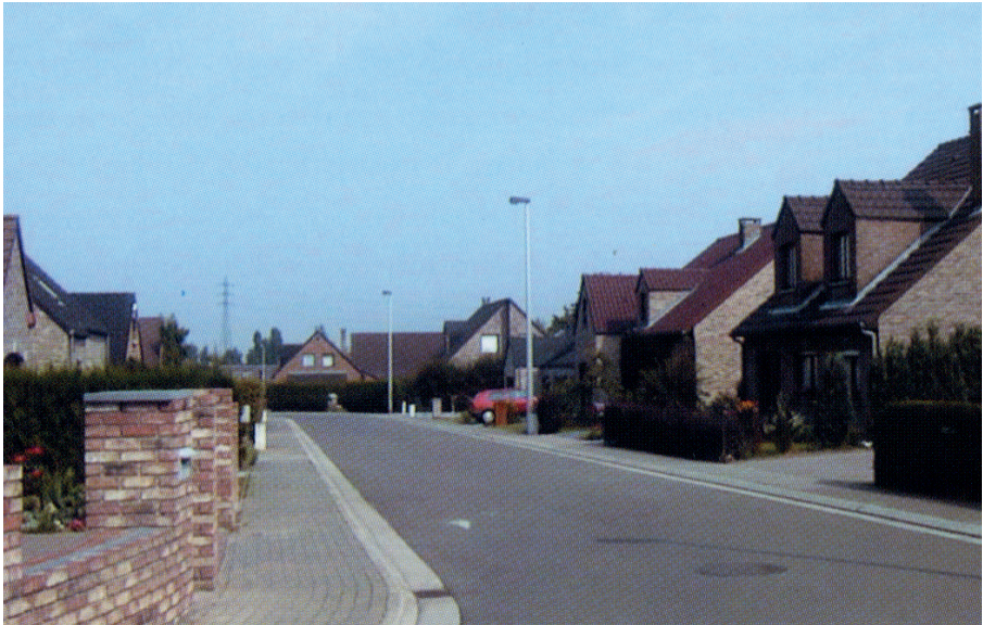
Lotissement avec ouverture de voirie. © L. Brück ÉTUDES ET DOCUMENTS CPDT 1, Les coûts de la désurbanisation, 2002, page 61
