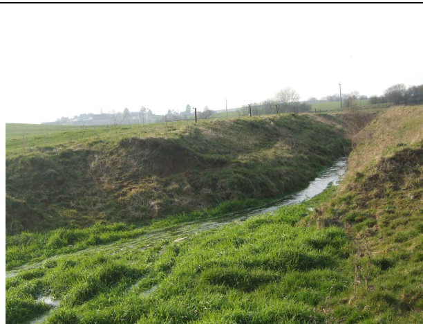
Ravinement (534-155) qui reçoit (via un drain les eaux qui se perdent en amont et qui présente de nombreux petits effondrements et un sol fort instable.
