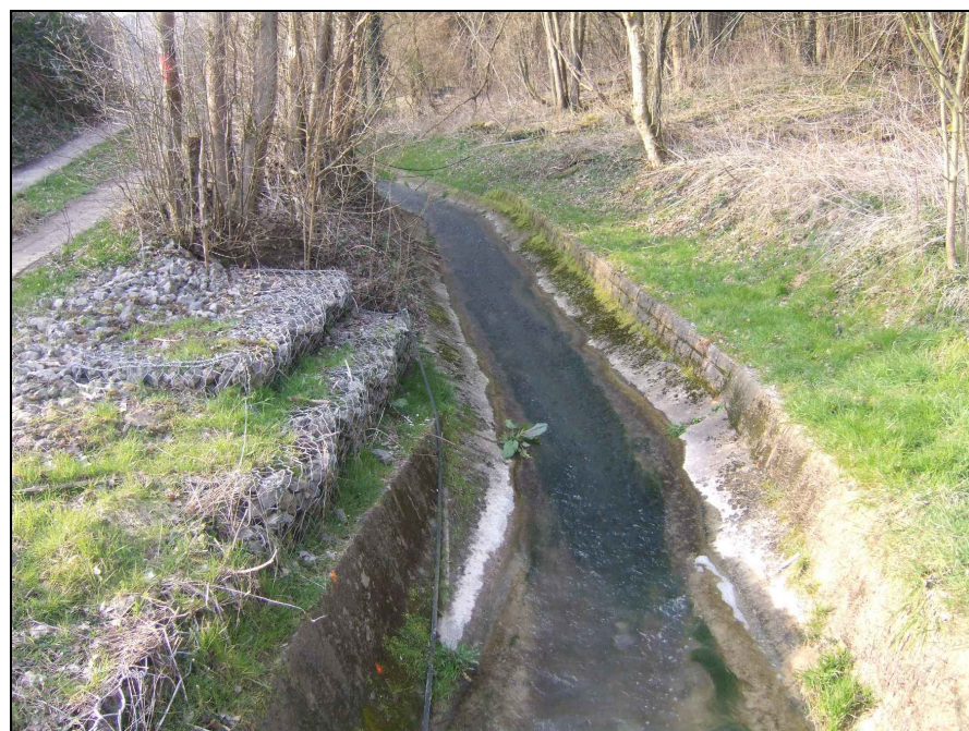
Fond du lit du Crupet bétonné dans sa partie aval pour protéger le captage.
